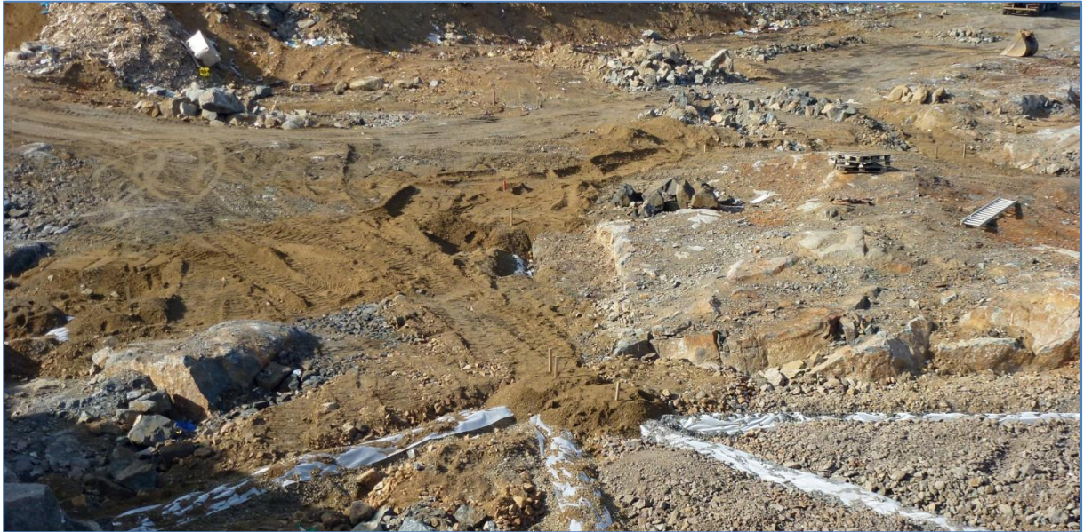
Mynd 15. Drenskurðirnir syðst í urðunarrein #4. Berggangurinn neðst í reininni er í drenskurðinum fyrir miðri mynd. Hann er um 5 m þykkur.
