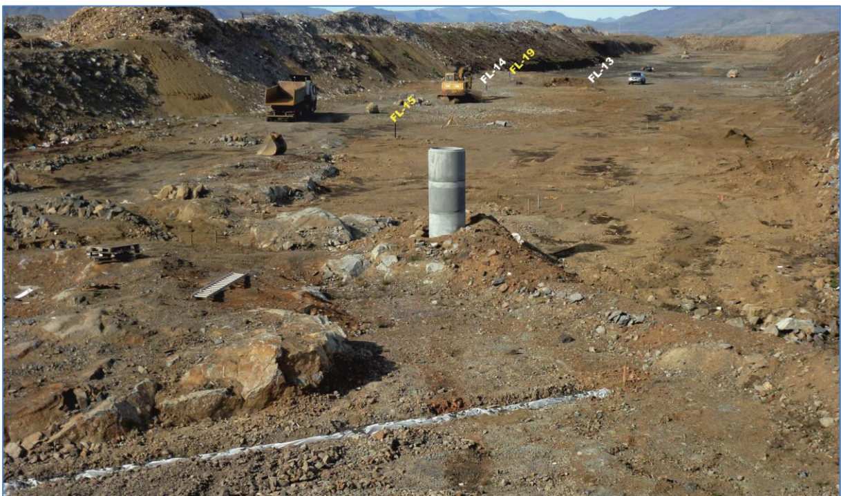
Mynd 14. Dílabasaltklappirnar neðan til í urðunarrein #4. Þær eru mjög heillegar. Fóðurrörið í borholu FL-15 má sjá greinilega, en auk hennar eru holur FL-13, FL-14 og FL-19 sýndar.
